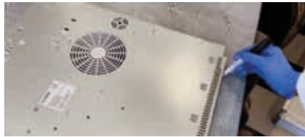
Mark the perimeter of the system on the back of the slab. Segnare il perimetro del sistema sul retro del top cucina.
